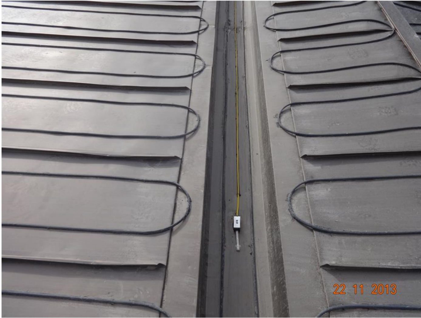
Yağmur oluğu ve çatı dere eteği uygulaması Uygulama yeri : ANKARA
